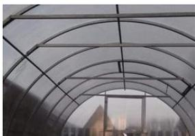
Распорка. Поперечная распорка изготовлена из оцинкованной трубы 30\*20. Увеличивает прочность конструкции и используется для подвязки растений (рекомендовано для теплиц 6 метров и более).
