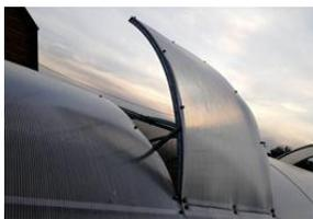
Форточка верхняя. Дополнительная форточка в крыше теплицы имеет уникальную конструкцию и способствует лучшему проветриванию больших теплиц (6 метров и более).
